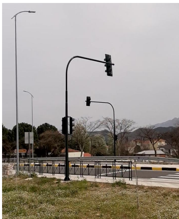
Εικόνα 18. Διάβαση πεζών - φανάρι πλησίον γέφυρας Γκίκα
