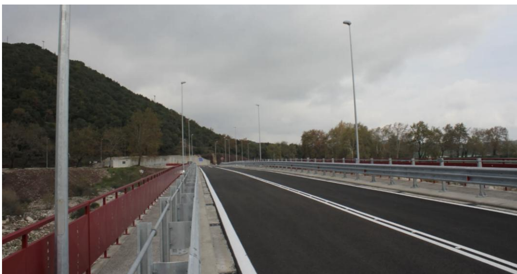
Εικόνα 14. Η νέα γέφυρα
