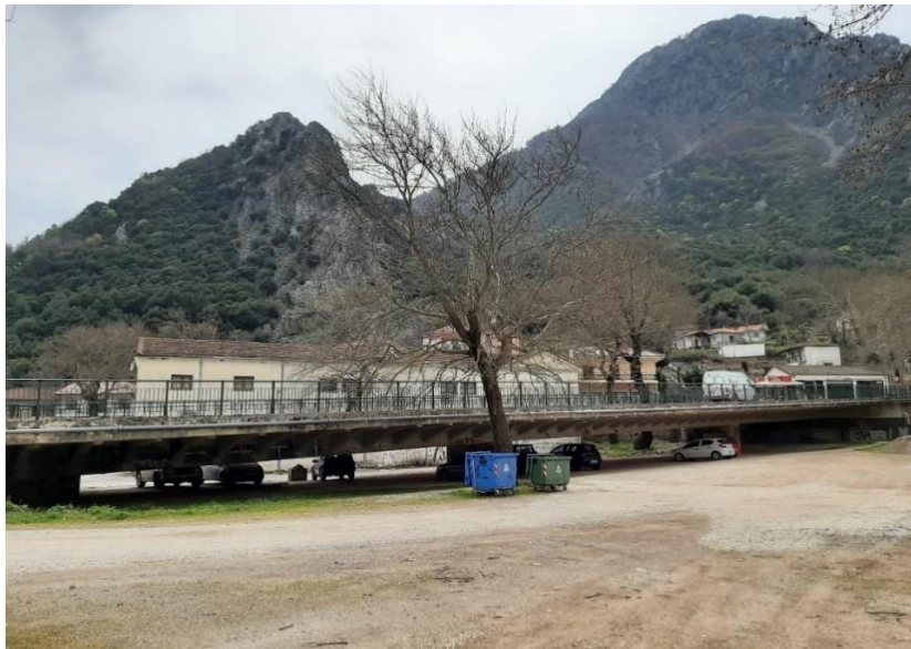
Εικόνα 31. Είσοδος από τη γέφυρα του Δημαρχείου
