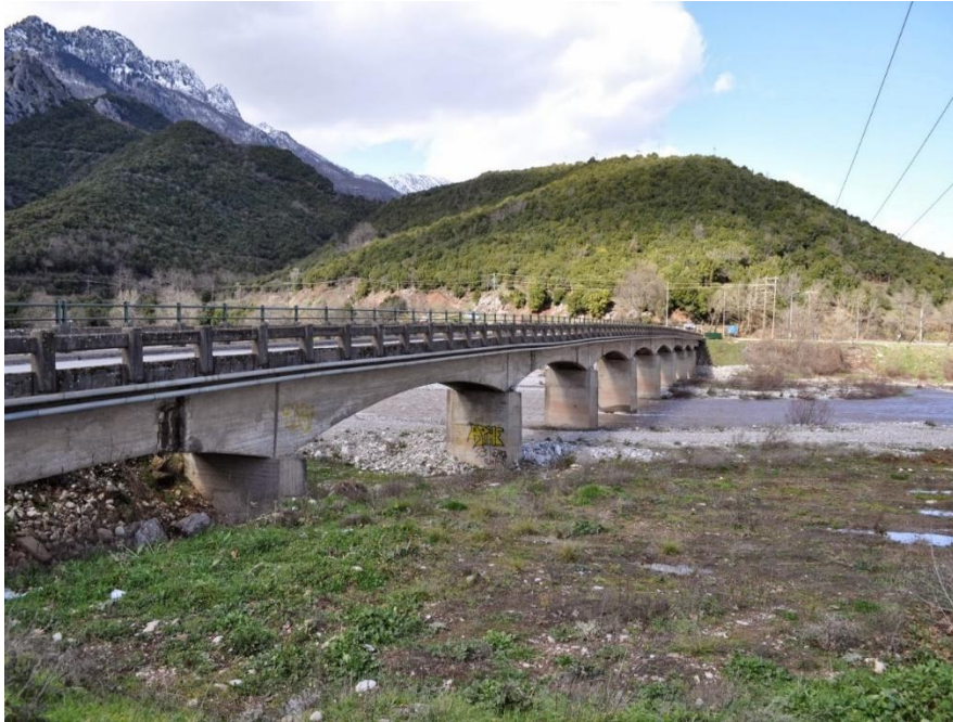
Εικόνα 13. Η γέφυρα Γκίκα
