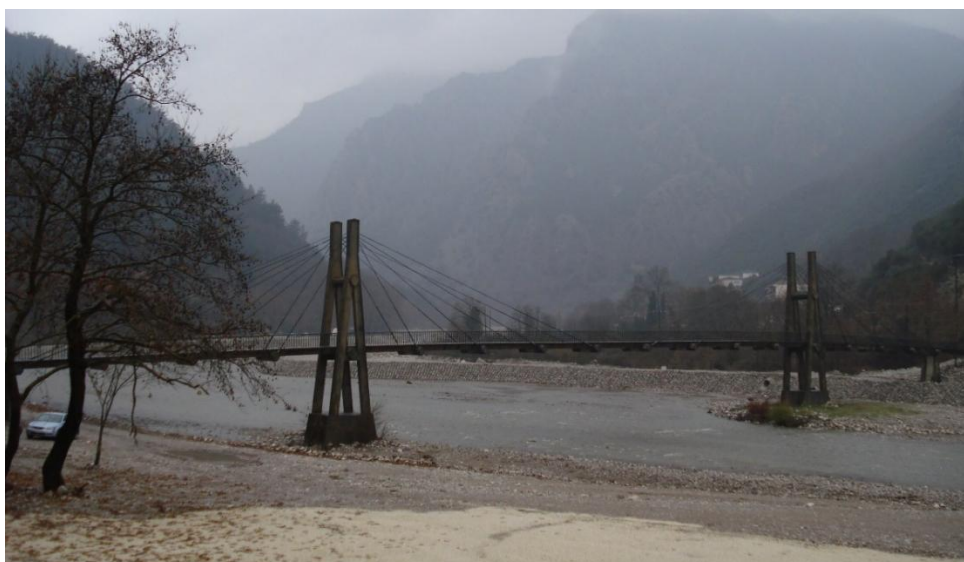
Εικόνα 10. Η Κρεμαστή Πεζογέφυρα
