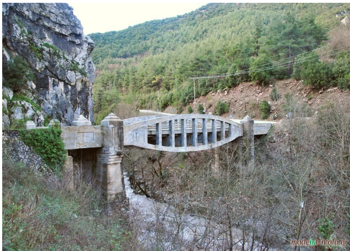
Εικόνα 12. Η γέφυρα Κονδύλη
