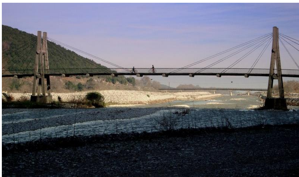
Εικόνα 11. Η Κρεμαστή Πεζογέφυρα
