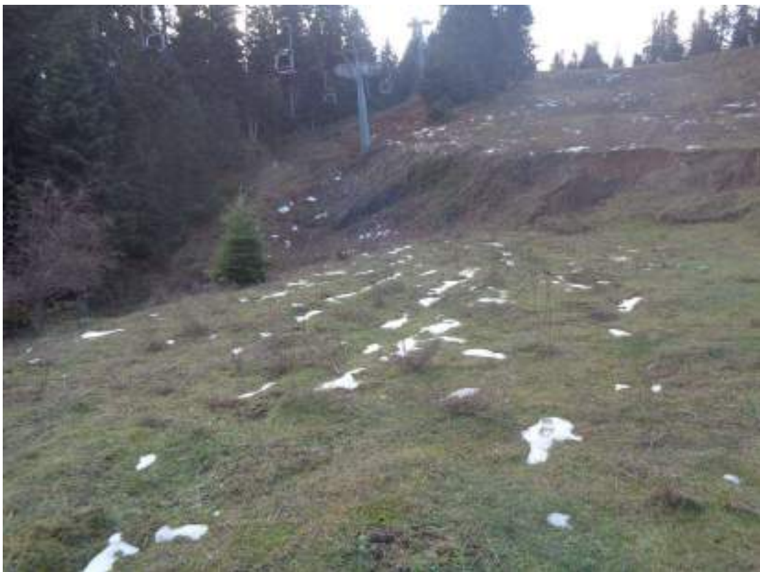
Φωτ. 19: Αποψη του 6 ου πυλώνα και της κατολίσθησης.
