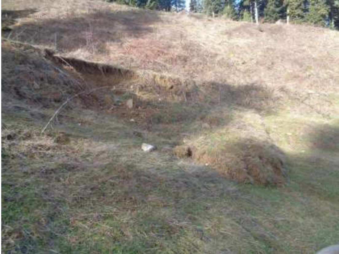
Φωτ. 16: Αποκόλληση υλικών από την στέψη της κατολίσθησης μετά την κακοκαιρία <<DANIEL>> και ολίσθηση αυτών στα υλικά της κατολίσθησης.
