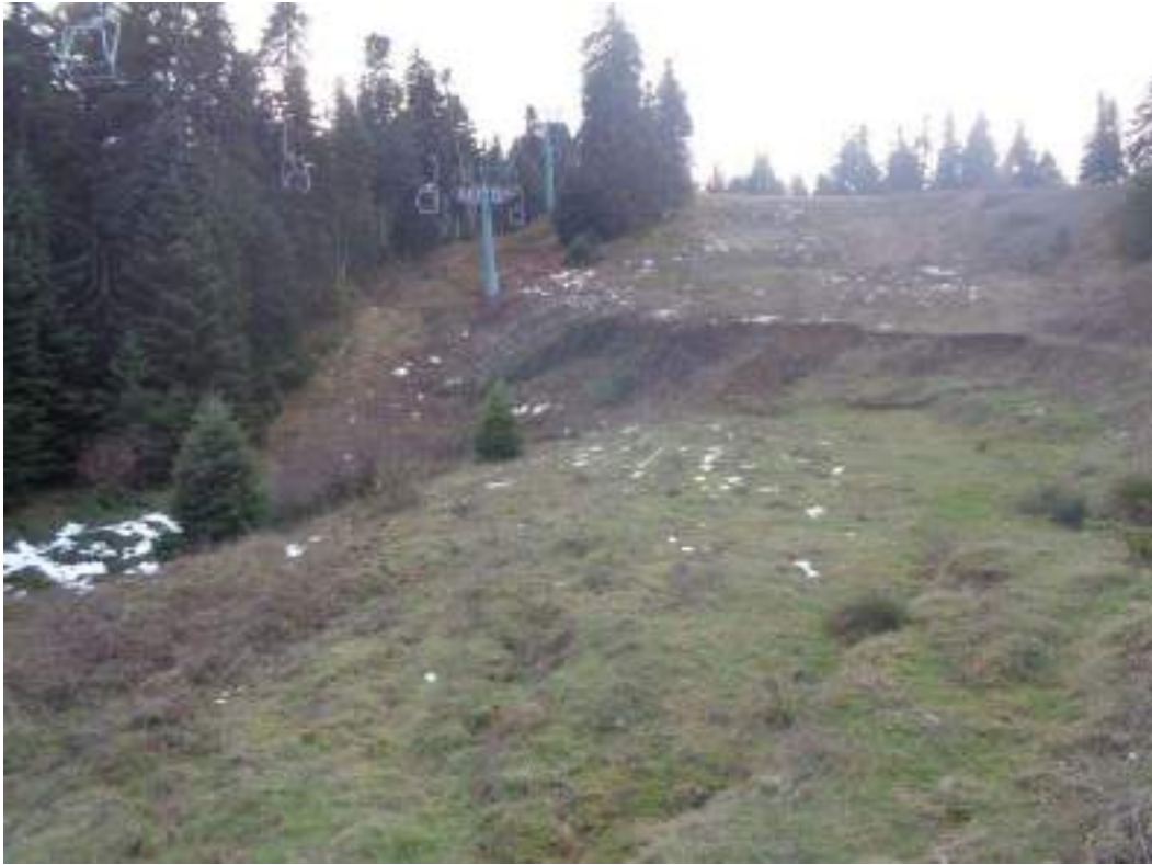
Φωτ. 2: Άποψη στέψης κατολίσθησης κατάντη 6 ου πυλώνα.
