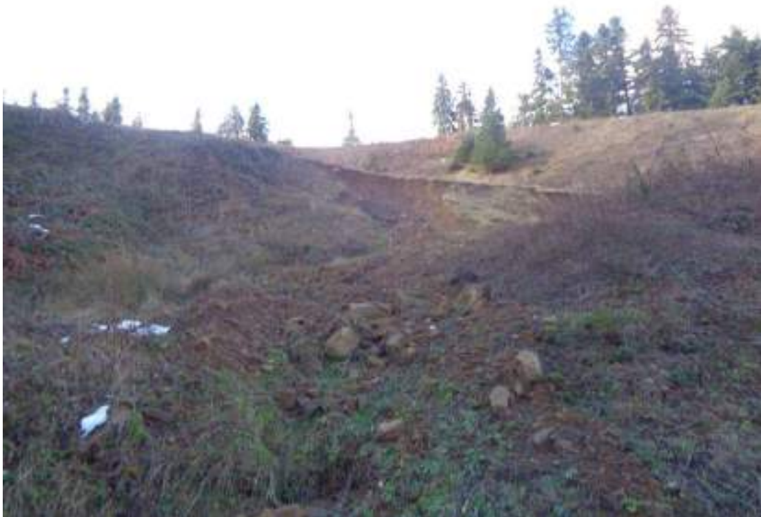
Φωτ. 15: Αποκόλληση υλικών από την στέψη της κατολίσθησης μετά την κακοκαιρία <<DANIEL>>.
