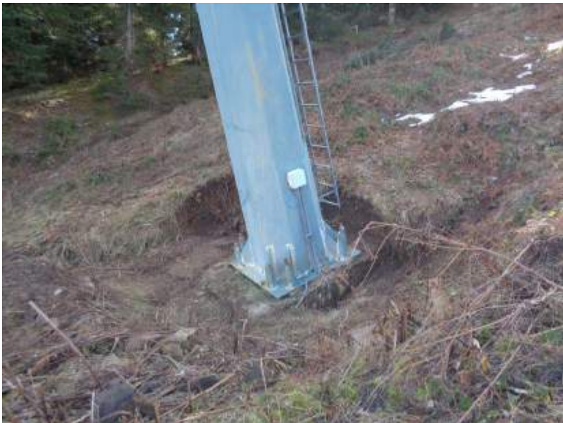
Φωτ. 22: Θεμέλιο 6 ου πυλώνα
