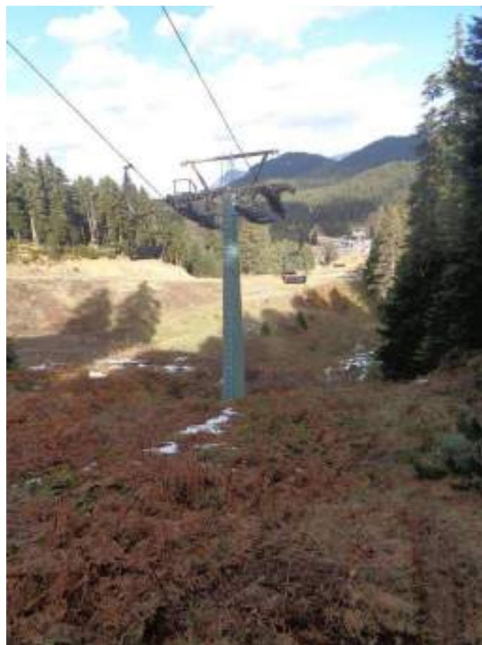
Φωτ. 27: Άποψη 6 ου πυλώνα
